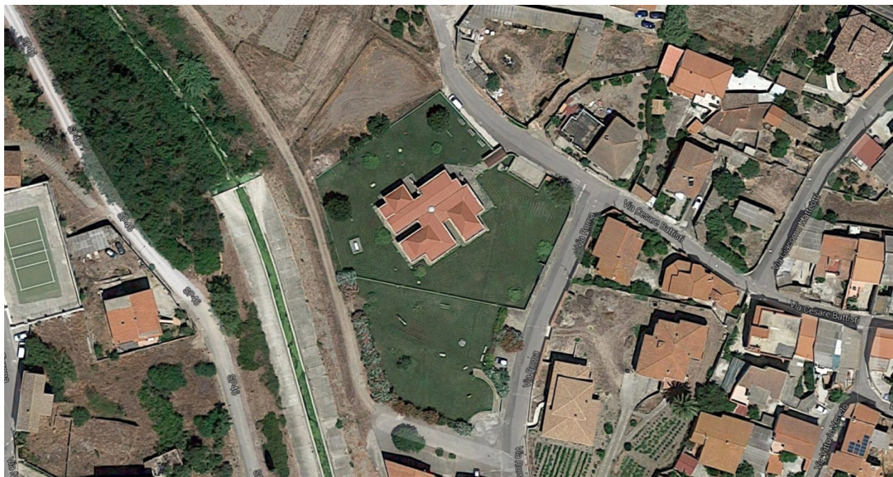
Figura 37 Vista aerea del contesto urbano
